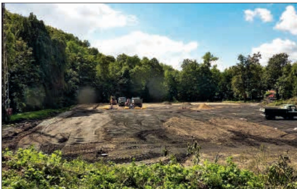
Výstavba hřiště s umělou trávou v roce 2010
